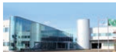
トリムエレクトリックマシナリー（高知県南国市）
